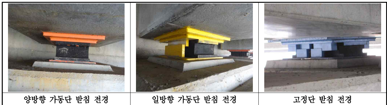
【사진 36.3.10】 교량받침 전경
