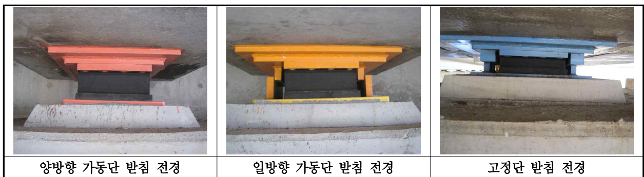
【사진 36.3.30】 교량받침 전경
