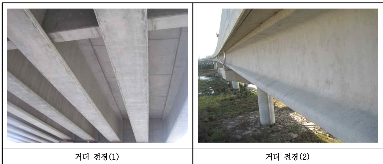
【사진 36.3.3】 거더 전경
