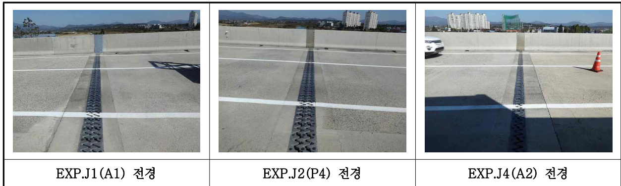
【사진 36.3.34】 신축이음장치 전경
