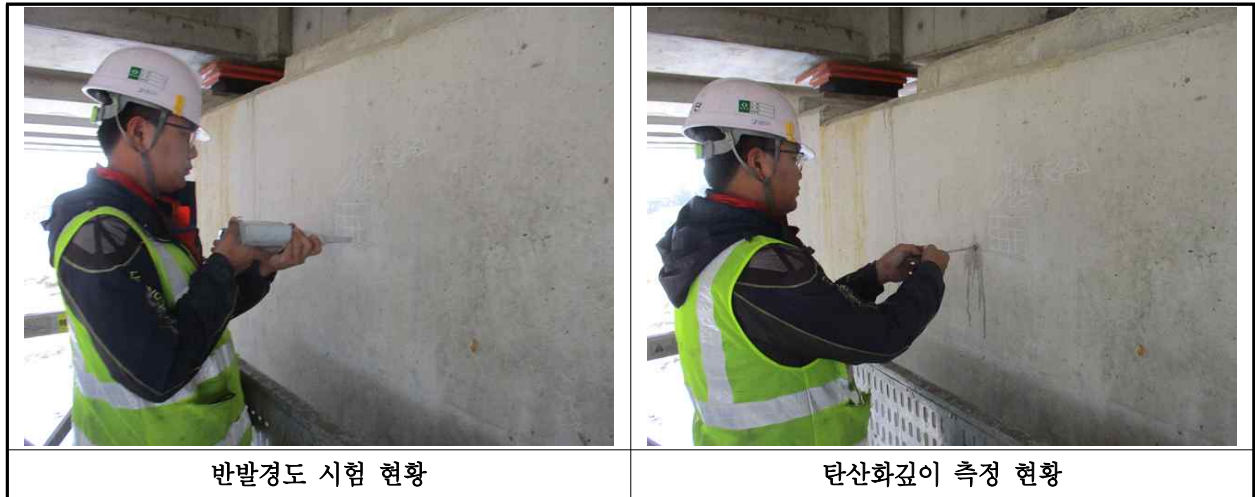
【사진 36.4.1】 콘크리트 내구성조사 현황
