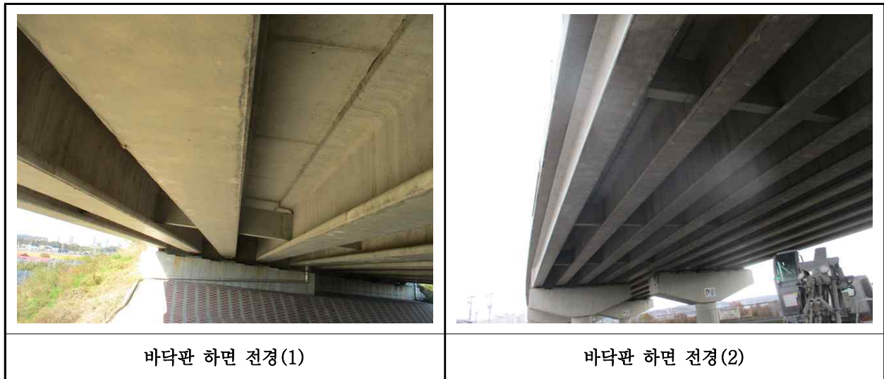
【사진 36.3.22】 바닥판하면 전경
