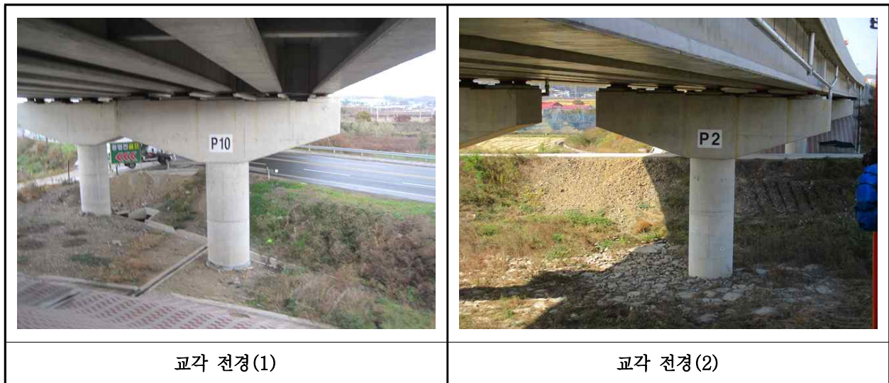
【사진 36.3.8】 교각 전경
