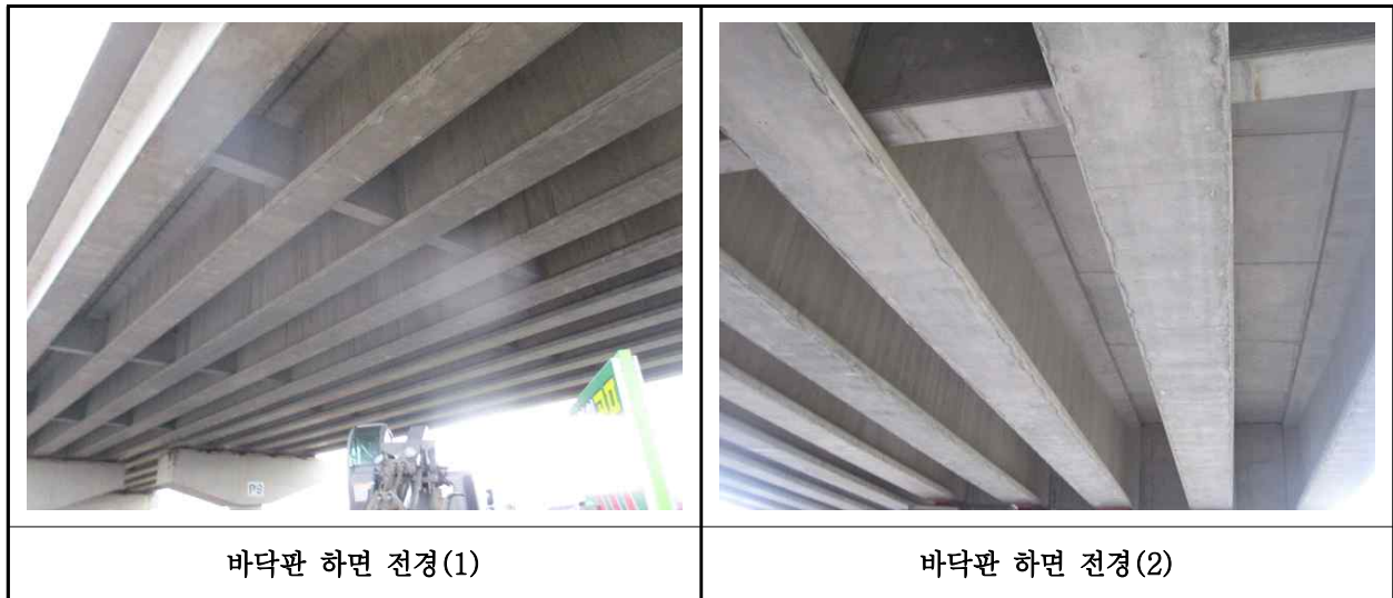
【사진 36.3.2】바닥판하면 전경
