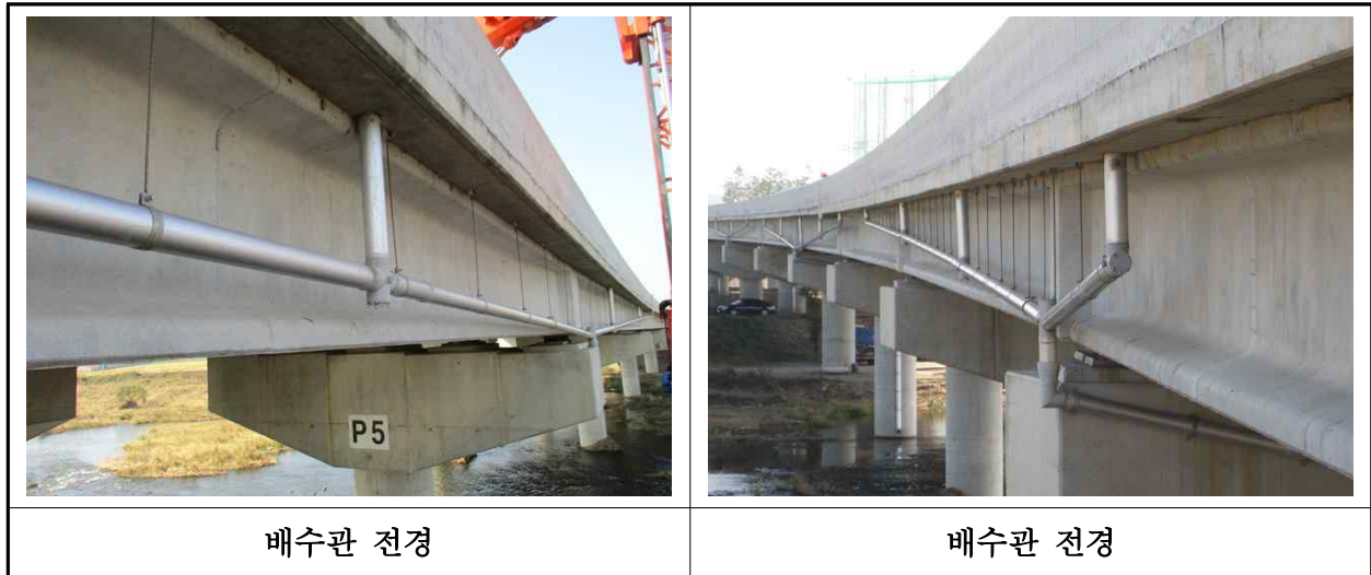
【사진 36.3.19】 배수시설 전경
