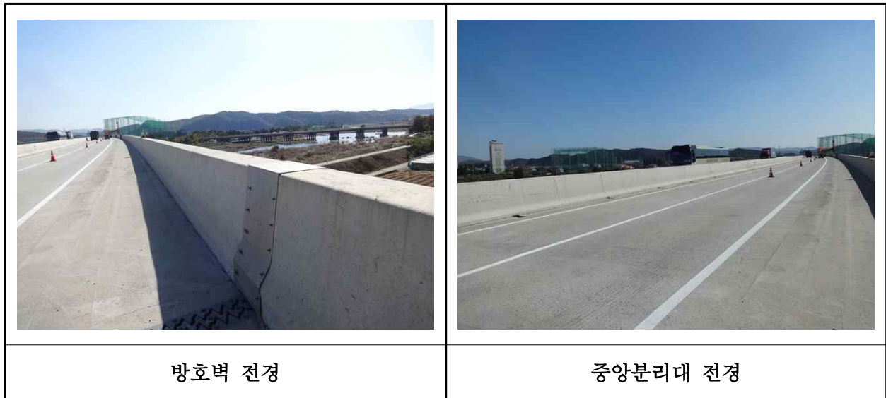
【사진 36.3.40】 방호벽 및 중앙분리대 전경
