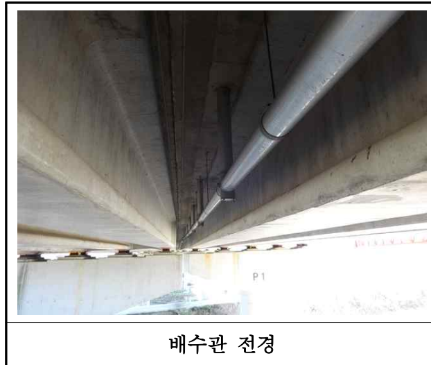
【사진 36.3.39】 배수시설 전경
