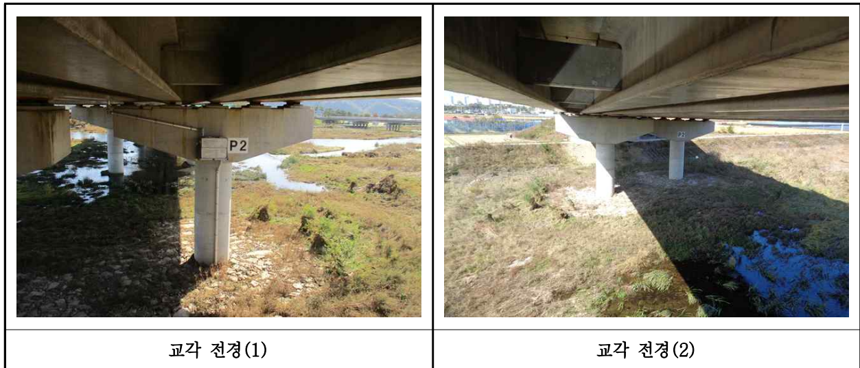
【사진 36.3.28】 교각 전경
